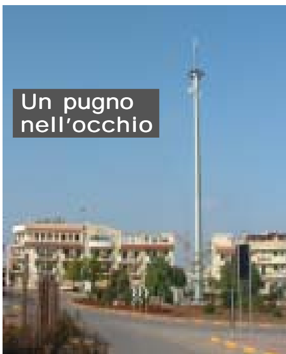
Il palo di p.zza dei Bersaglieri non ancora completo di antenne
